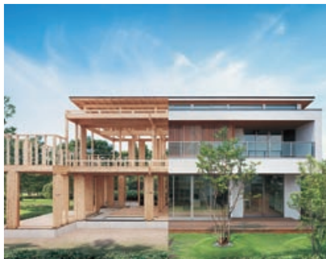
当社独自のビッグフレーム構法により、大空間設計が可能で間取りの可変性が高い注文住宅商品「BF-Si(ビーエフ・エスアイ)」
